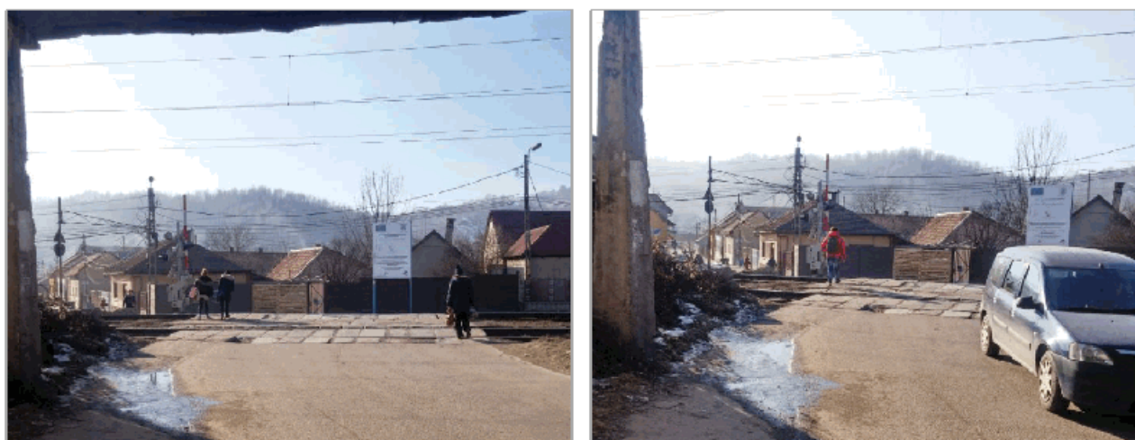
Figura 2.61. Trecere la nivel cu calea ferată nesigură pentru pietoni (Strada Timișoara).
